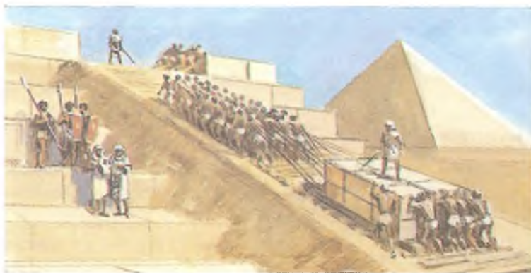
Строительство пирамиды. На деревянных полозьях каменный блок тащат вверх. Рисунок нашего времени.
