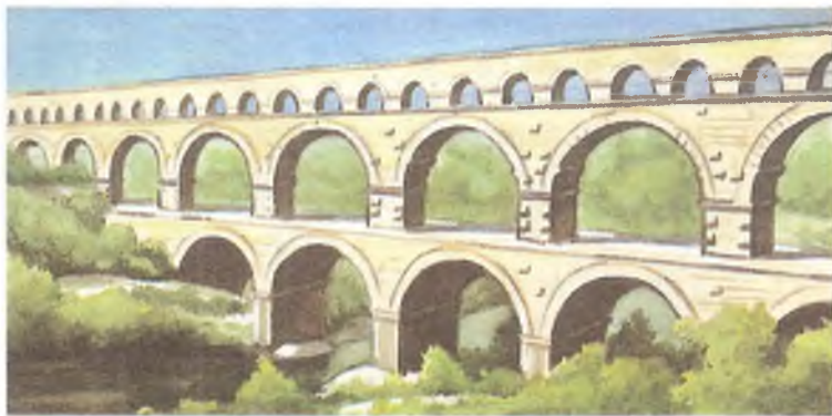
Римский мост в Галлии (нынешней Франции). По мосту проходил водопровод. Высота моста над уровнем реки почти 50 метров. Перекрытия между опорами имеют форму полукруглых арок .
